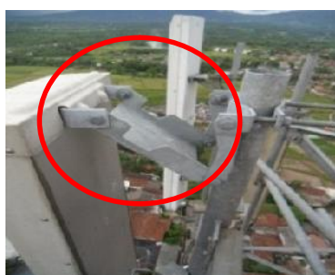
Gbr 7. Bracket atas Antena [2]
