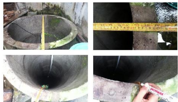
Gbr. 2 Observasi kondisi sumur
