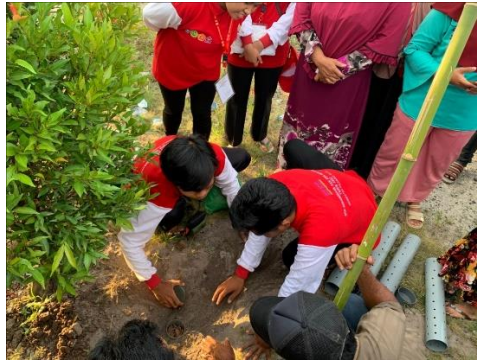
Gambar 8. Penambahan sampah organik ke dalam pipa biopori dan penutupan pipa
