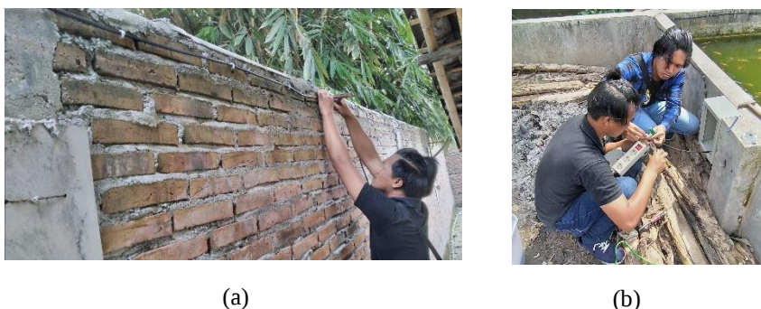
Gambar 8 Instalasi (a) kabel, (b) stop kontak
