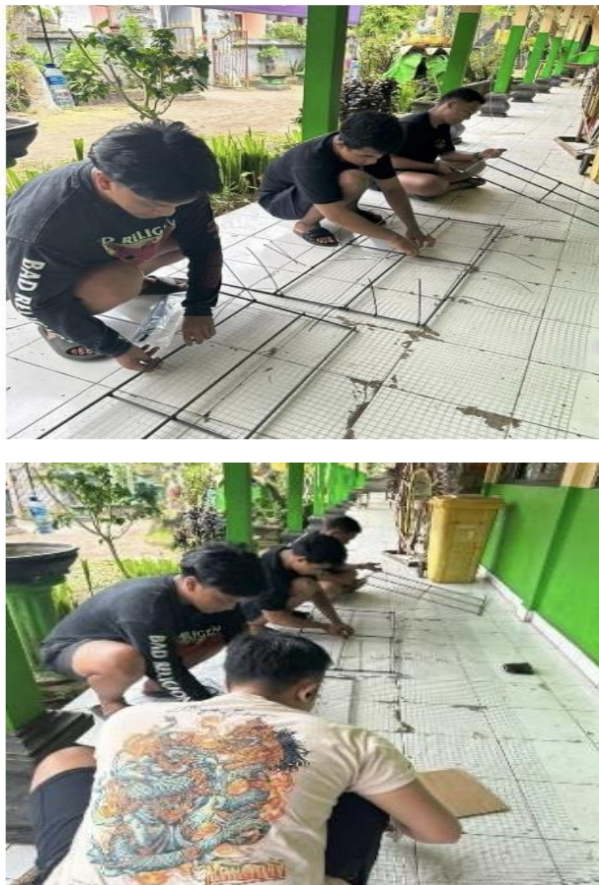
Gambar 2 Pembuatan Saringan untuk Selokan
