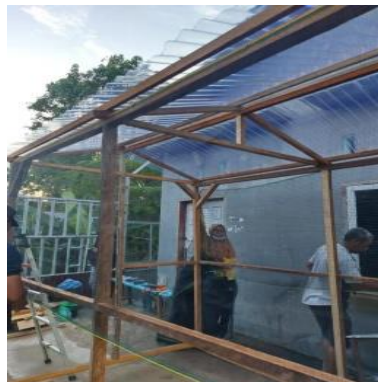
Gambar 8 Proses Pembuatan Instalasi Rumah Hidroponik
