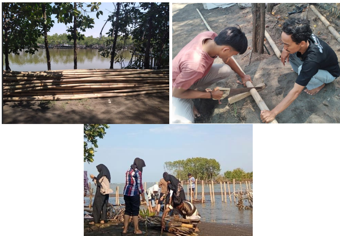
Gambar 4. Proses Pembuatan Bamboo Submerged Breakwater
