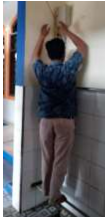
Gambar 6. Pemasangan Wudhu Smart
