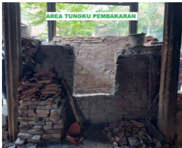
Gambar 11. Tungku pembakaran (sisi timur)
