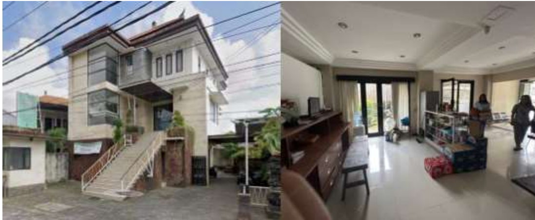
Gambar 1. Kondisi eksisting bangunan koperasi
