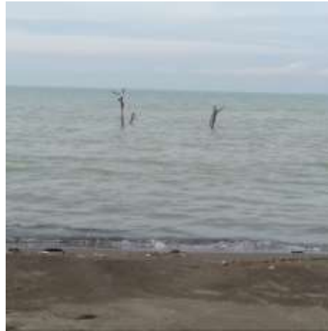
Gambar 5. Hasil pemasangan pancang Cemara
