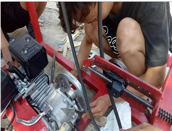
Gambar 4. Pemasangan Pulley D = 203 mm
