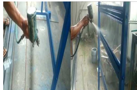
Gambar 7. Proses pengecatan besi kerangka
