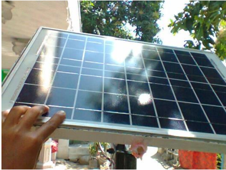
Gambar 3.8 Pemasangan Sel Surya
