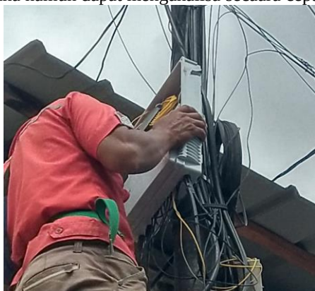
Gbr. 4 proses pengecekan dengan senter laser di ODP
