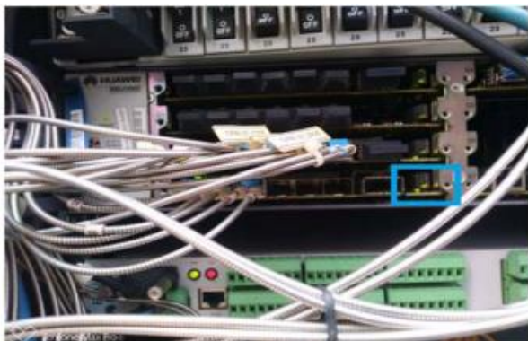
Gambar. 21 Lampu indicator pada WBBP kembali menyala setelah dilakukan penggantian modul WBBP.
