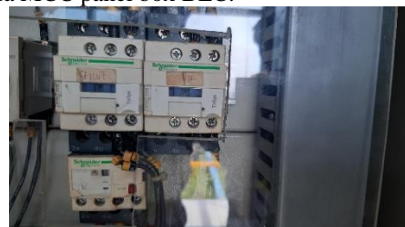
Gambar 9 Kontaktor Rotating Chute
