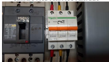
Gambar 6 MCB Pada MCC Panel BLC
