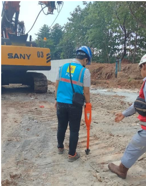
Gambar. 3 Penitikan lekukan kabel SKTM selama pelacakan
