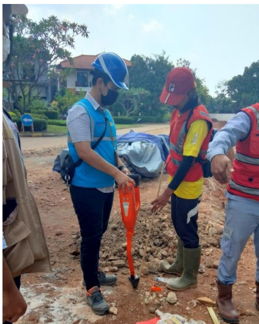
Gambar. 4 Pemberian patok (penanda) pada lekukan kabel
