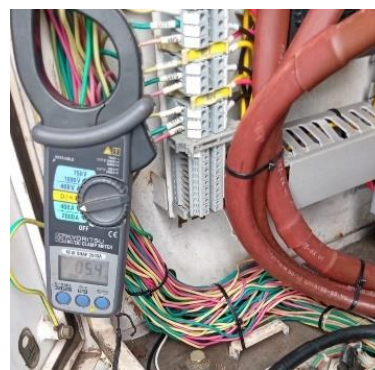
Gambar. 3 Hasil Pengukuran Arus Fan
