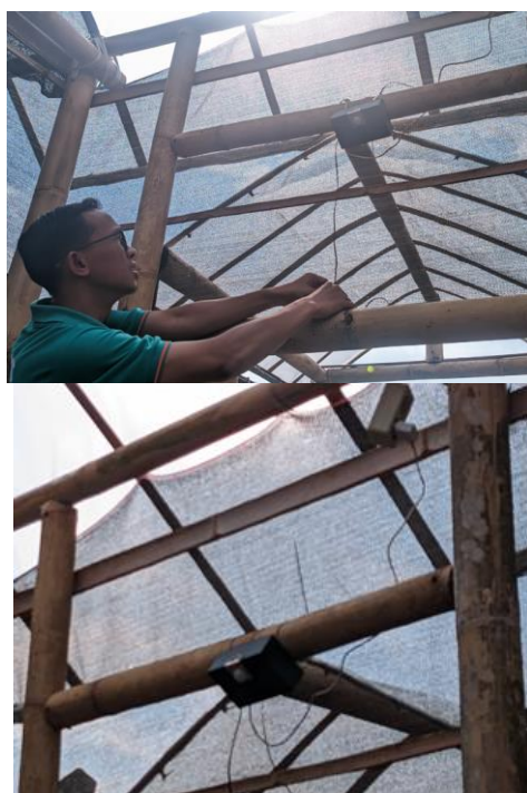
Gbr. 7 Pemasangan perangkat kewanaman di greenhouse
