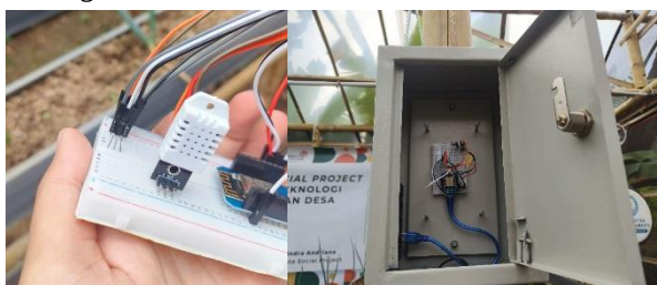
Gbr.3 Pemasangan Perangkat Sensor suhu pada Green House
